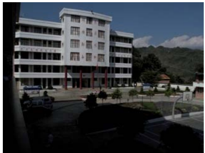
Scuola tecnica realizzata in Yunnan dalla Coop. Italiana
